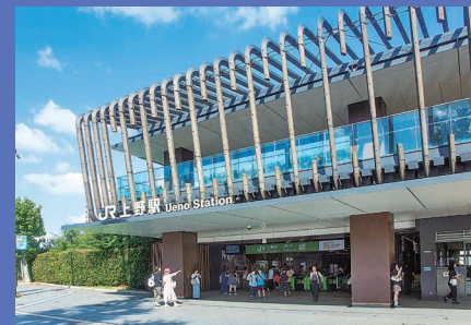
2020年に完成した公園口駅舎。25年には国際的な鉄道デザイン賞であるブルネル賞を受賞
