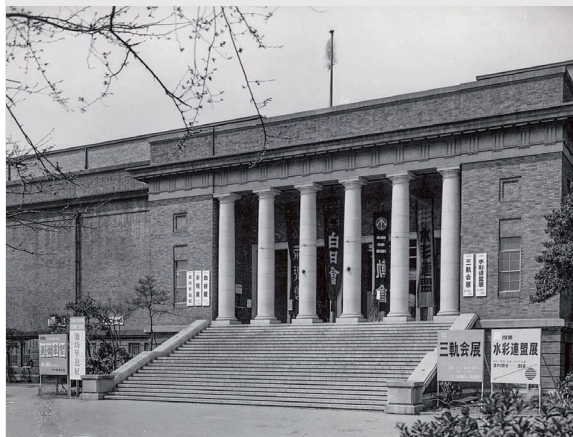
旧館正面階段（1960〔昭和35〕年頃）
